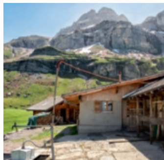
Der neue Anbau der Alphütte hat sich bewährt.
