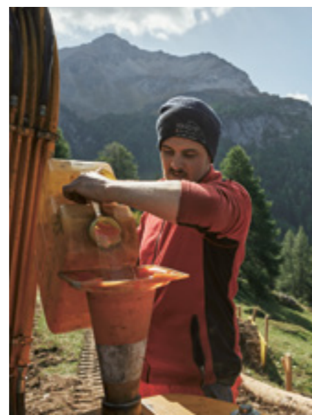
Kreativität hilft: Eine Verkehrspyllone taugt beim Betanken des Baggers auch als Trichter.
