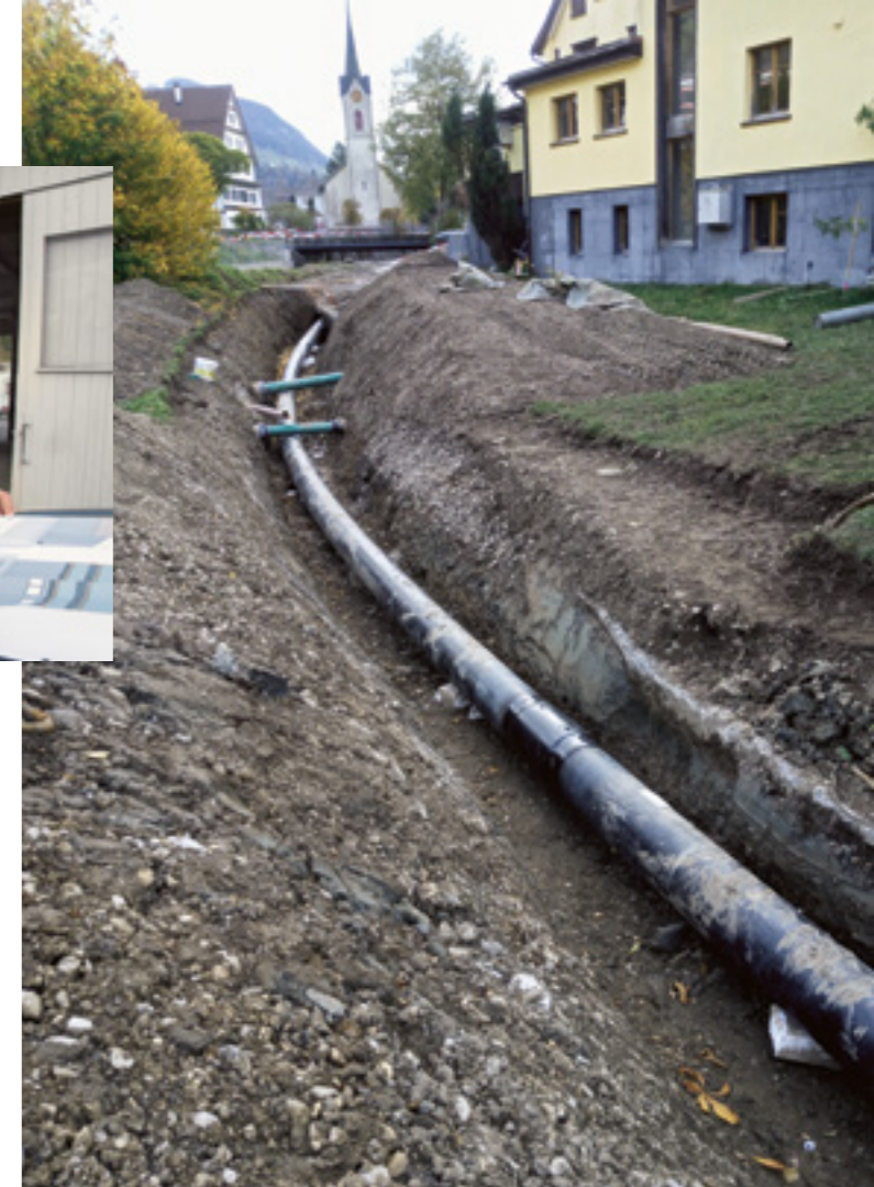
Zwei Kilometer lang ist die unterirdische Warmwasserleitung zwischen den Dörfern Alt St. Johann und Unterwasser.
